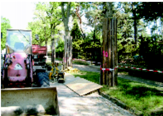
Abb. 9: Schutzmaßnahmen während der Bauausführung (Baumschutz)
