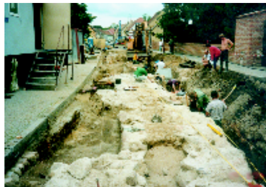
Abb. 4: Archäologische Untersuchungen, Freilegung historischer Fundamente
