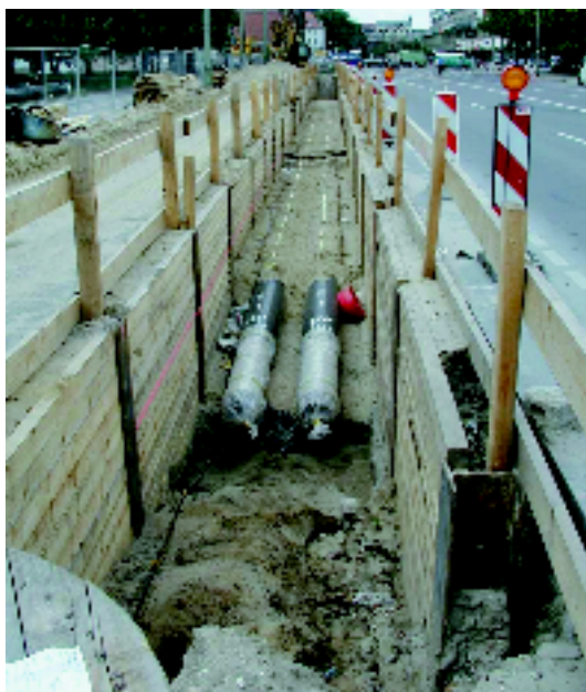
Abb. 2: Verbauter Rohrgraben
