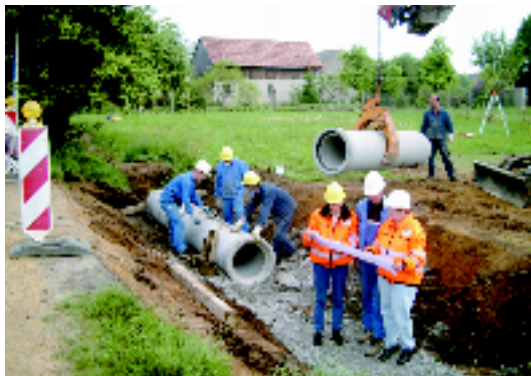
Abb. 13: Überwachung einer Baustelle
