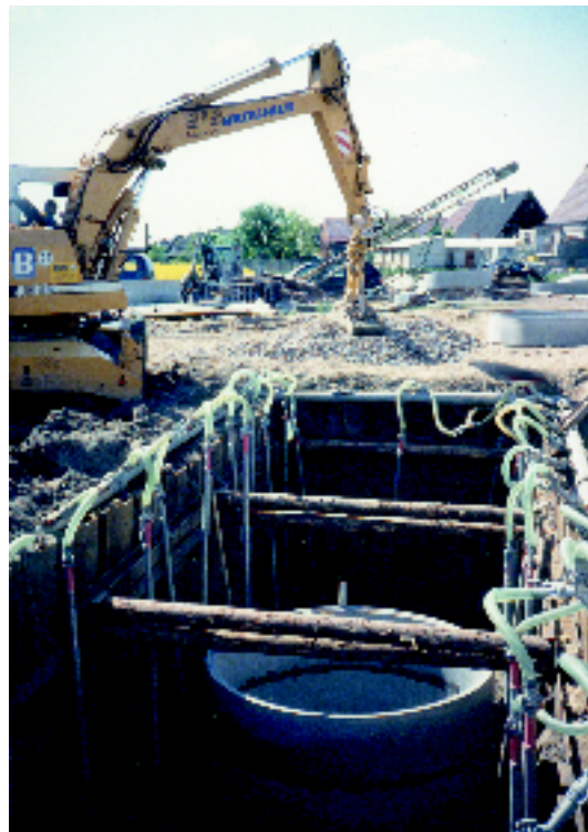
Abb. 5: Grundwasserentnahme, Schachtbaugrube
